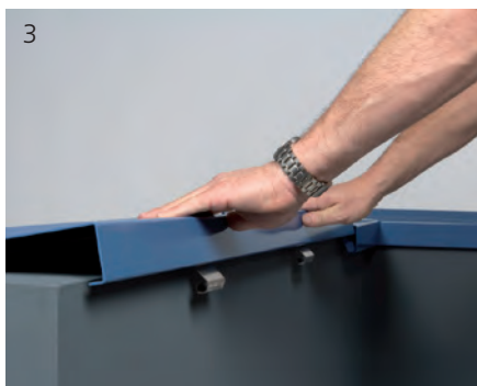
3 De muurafdekkap wordt over de RVS-veer gedrukt.
