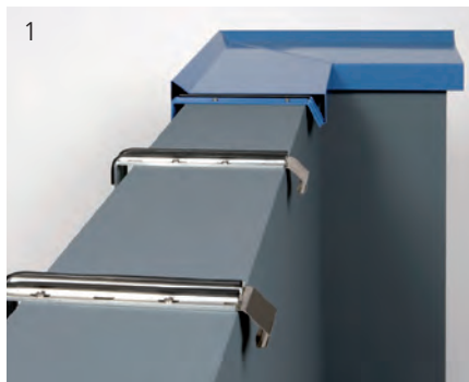
Eerst wordt de klang bevestigd.
